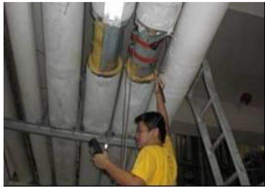
冰水流量測量與調整，使各支管水量平衡及達到設計值，以均衡分配冷源
