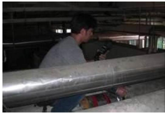
進行冰水泵壓差感測器之移裝與校正，以達到變水量節能運轉功能
