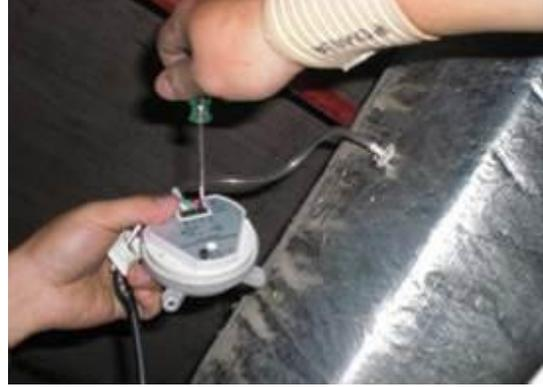
進行空調箱壓差感測器之移裝與校正，以達到變風量節能運轉功能
