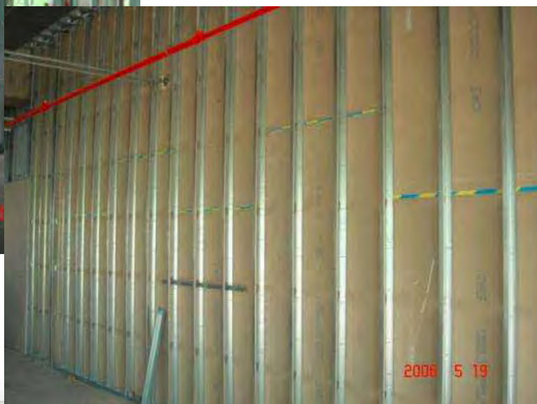
室內隔間均採用輕量乾式隔間牆
