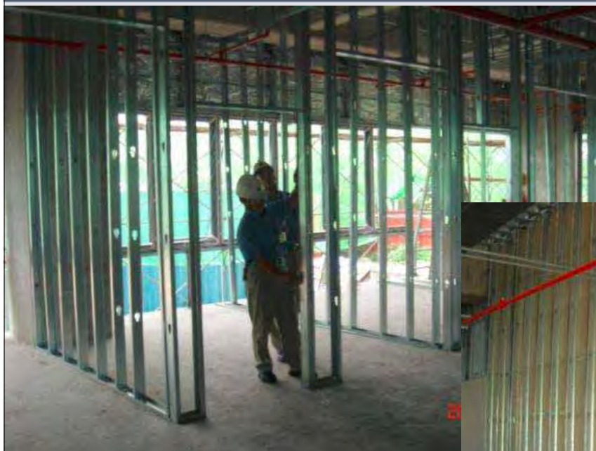
室內隔間均採用輕量乾式隔間牆
