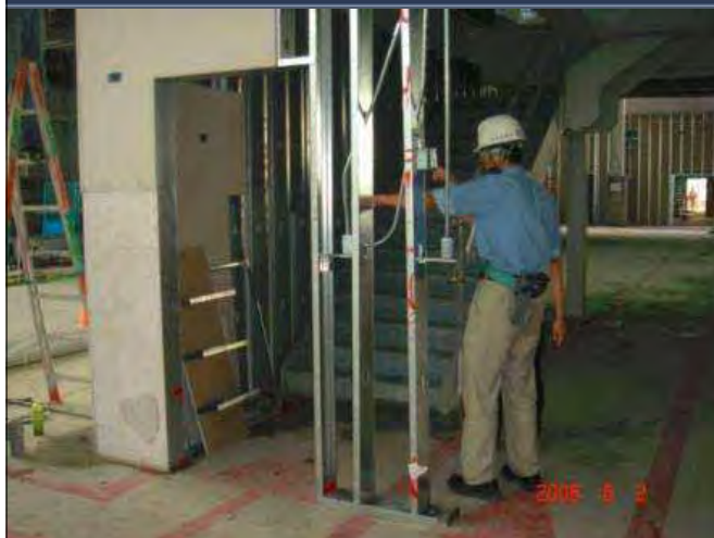
室內隔間牆施工照片
